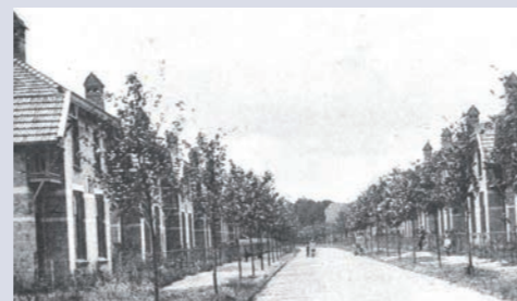
Dubbele woningen voor onderofficieren aan de Wilhelminalaan te Harderwijk, gebouwd in 1912 door de plaatselijke vereniging.
