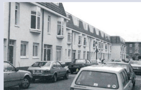
Het oudste Haagse complex van Ons Belang in de Marekstraat (Den Haag), gebouwd in 1923 en na de renovatie in 1988 aan de buitenkant voorzien van gevelisolatie.
